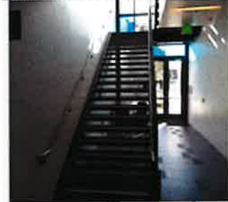
8. Stosare, Budowa + Budowa Balustrady - Czynności Bez Inwest
