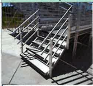
8. Stosare, Budowa + Budowa Balustrady - Czynności Bez Inwest
