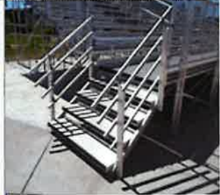
8. Stosare, Budowa + Budowa Balustrady - Czynności Bez Inwest
